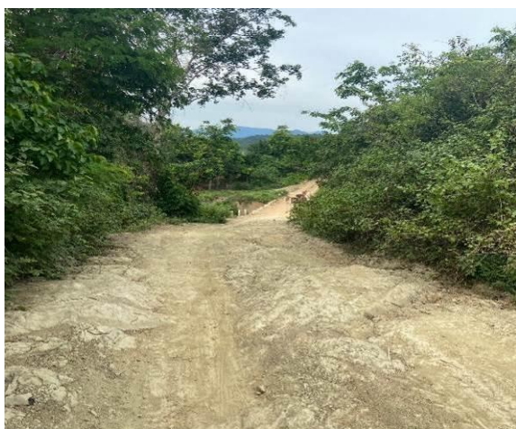
Mặt đường hiện hữu hư hỏng nặng, lởm chởm đá rất dễ gây trơn trượt đối với các phương tiện lưu thông
